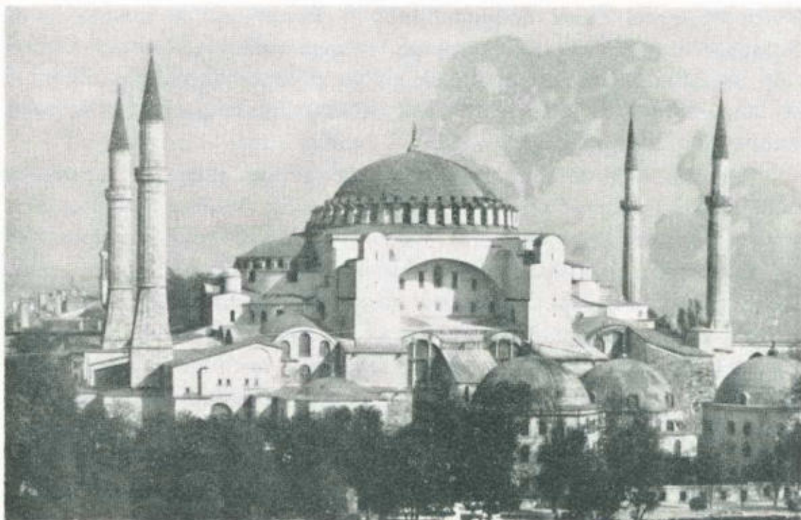
Costantinopoli: S. Sofia. Esterno. La chiesa che per lungo tempo rimase la più grande del mondo, venne realizzata per volere dell'imperatore Giustiniano in poco più di cinque anni (532-537). Essa ha una lunghezza di m. 80,9 e una larghezza di m. 69,7; la sua cupola ha un diametro di m. 33 ed è alta m. 55,6.
