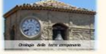
Crociolo della torre campanaria
