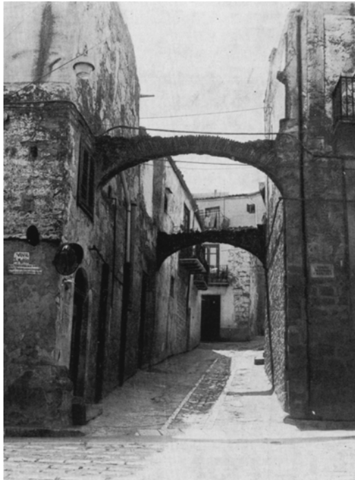
Quello che resta del portico all'imboccatura di via Ugo Bassi sul corso Vittorio Emanuele.
