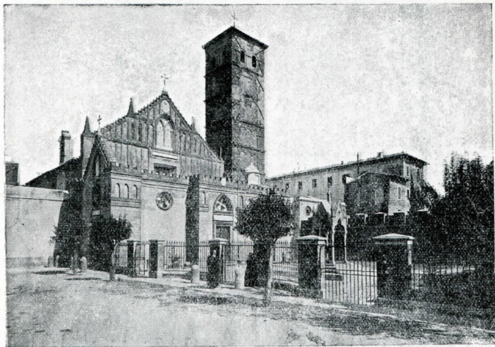
7. — Prospetto della Basilica prima del restauro.
