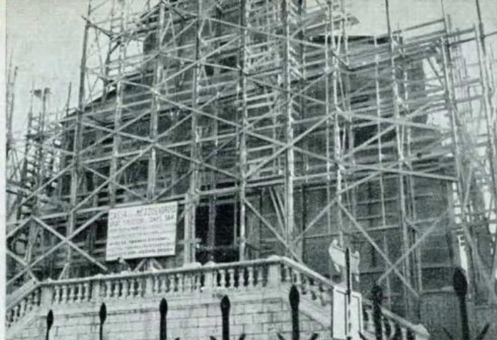
La Cattedrale di Piana degli Albanesi durante i lavori di restauro (1964).
