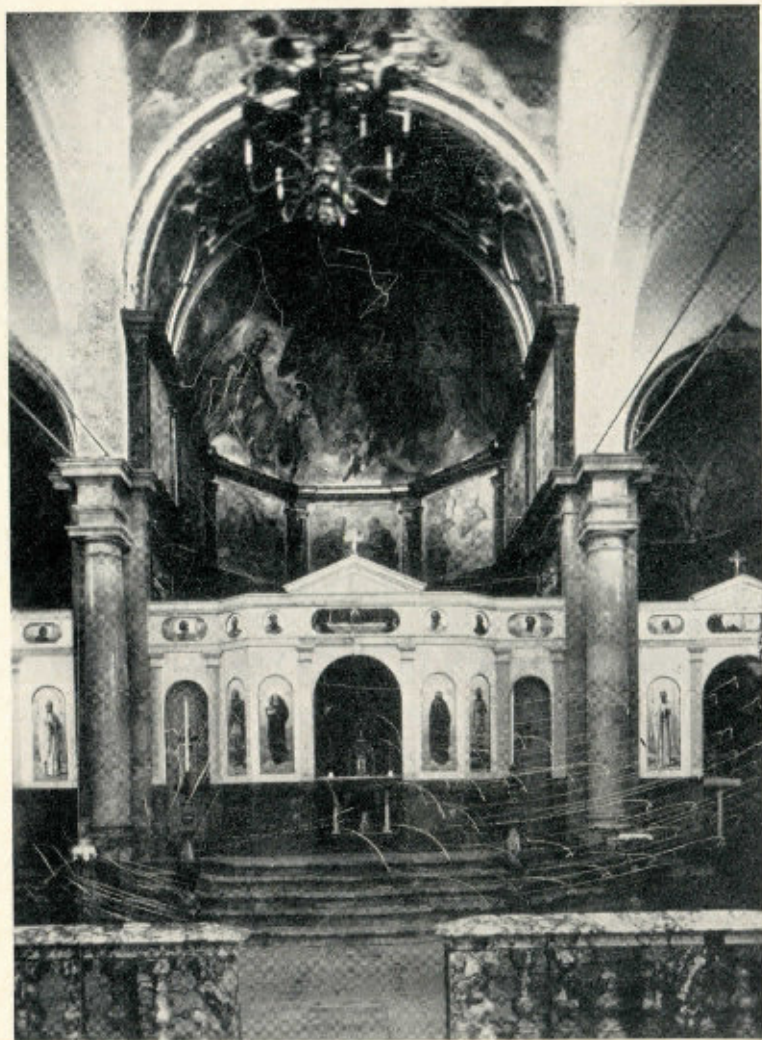
Interno della Cattedrale di S. Demetrio prima dei lavori del 1960.
