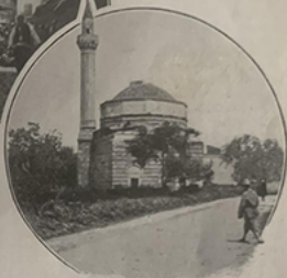
LA VECCHIA MOSCHEA FRA GLI ULIVI, SULLA STRADA DEL PORTO.
