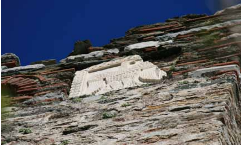
3. Il pannello araldico in marmo bianco scolpito in altorilievo con un'aquila da una sola testa. È posizionato verso il vertice della torre. Foto Marco Merlini
