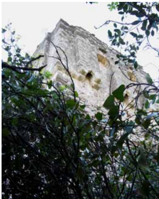
2. La torre di Amalfion "mangiata" dalla vegetazione. Foto Marco Merlini
