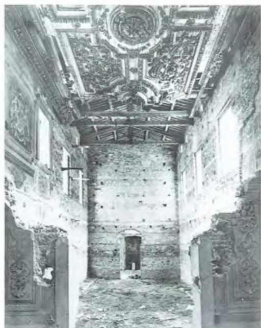
Fig. 36A. I resti dell'originario divisorio del bema dopo lo smontaggio della paratia lignea nel corso dei primi lavori di tamponamento e risistemazione dell'edificio della SS. Annunziata, A.F.S. di Pisa.
