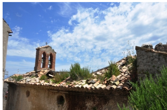
Vista verso Nord-Est
